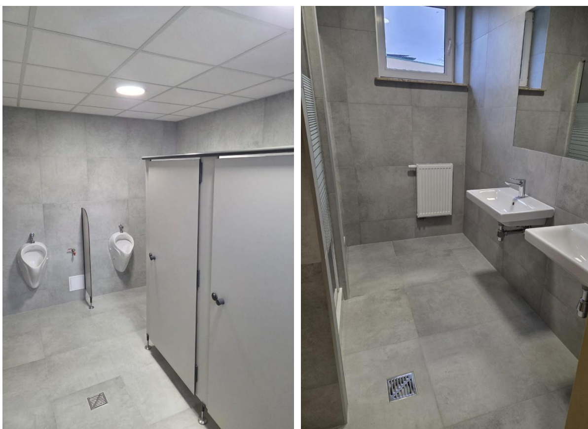
Zdjęcie nr 32. Wyremontowane pomieszczenia sanitarne JRG
