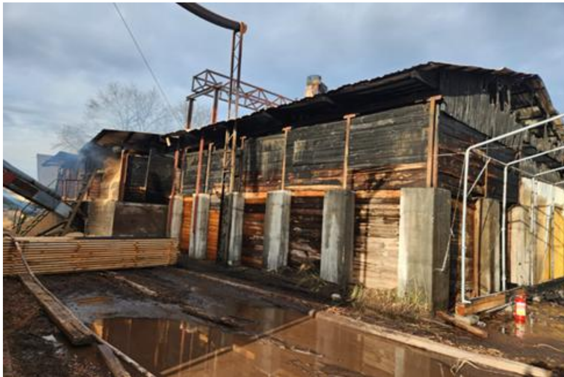
Zdjęcie nr 14. Pożar hali magazynowej tartaku przy ulicy Białobrzeskiej 49 w Tomaszowie Mazowieckim
