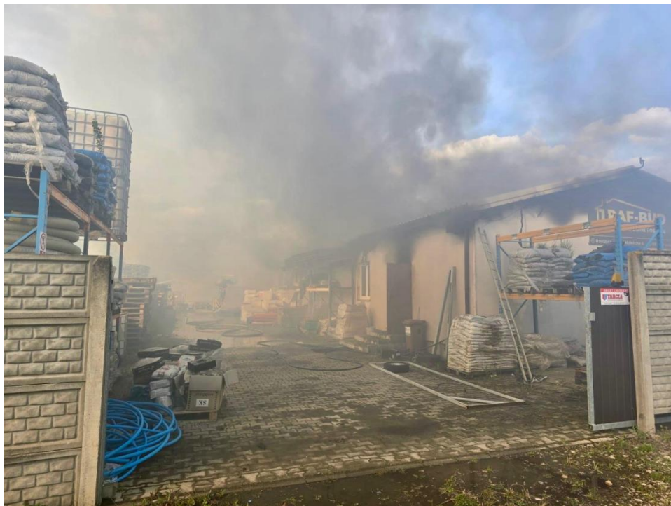
Zdjęcie nr 5. Pożar marketu budowlanego przy ulicy Spółdzielców 4 w Rzeczycy.
