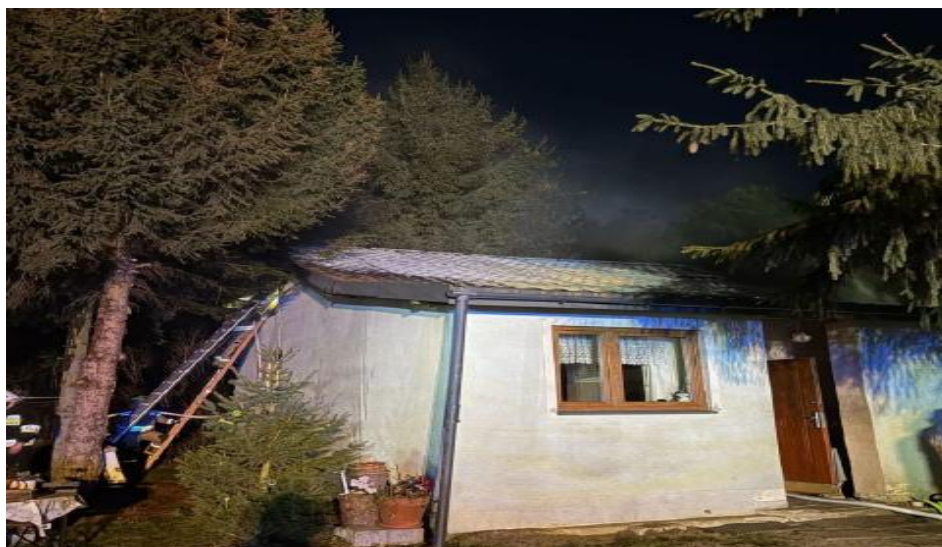
Zdjęcie nr 4. Pożar poddasza w domu jednorodzinnym w miejscowości Stanisławów
