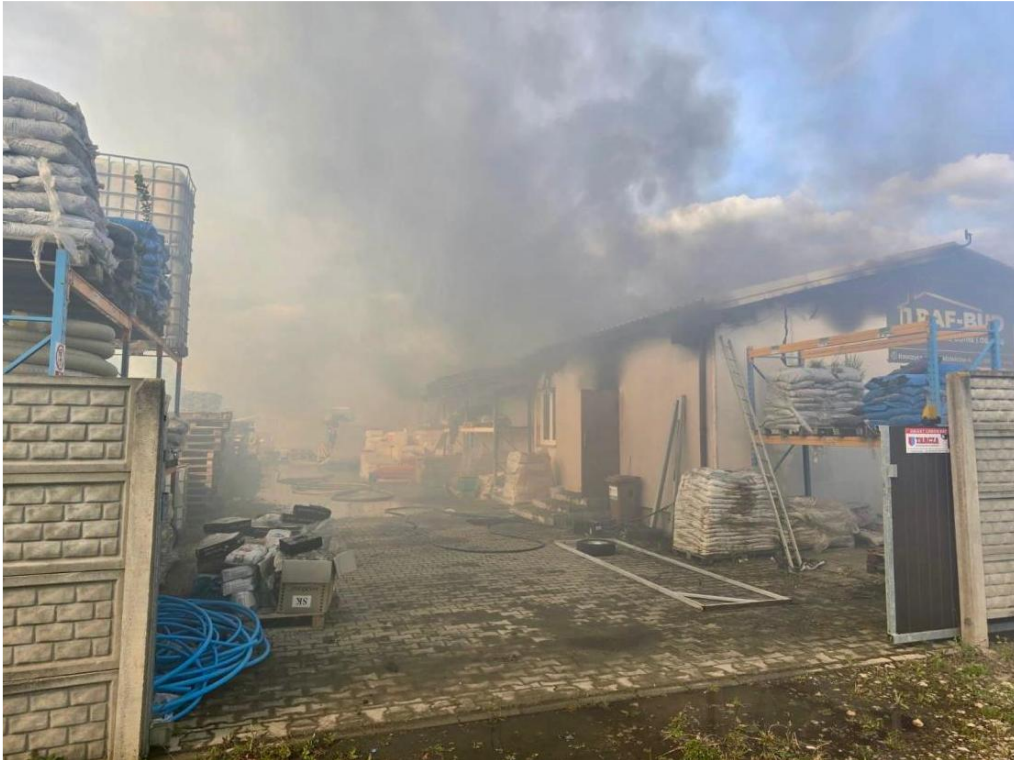
Zdjęcie nr 6. Pożar marketu budowlanego przy ulicy Spółdzielców 4 w Rzeszycy.
