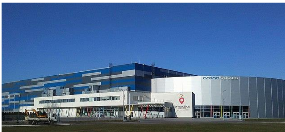
Ryc. 2. Arena Lodowa w Tomaszowie Mazowieckim
