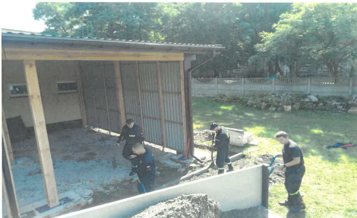
Utwardzenie posadzki w budynku magazynowym.
