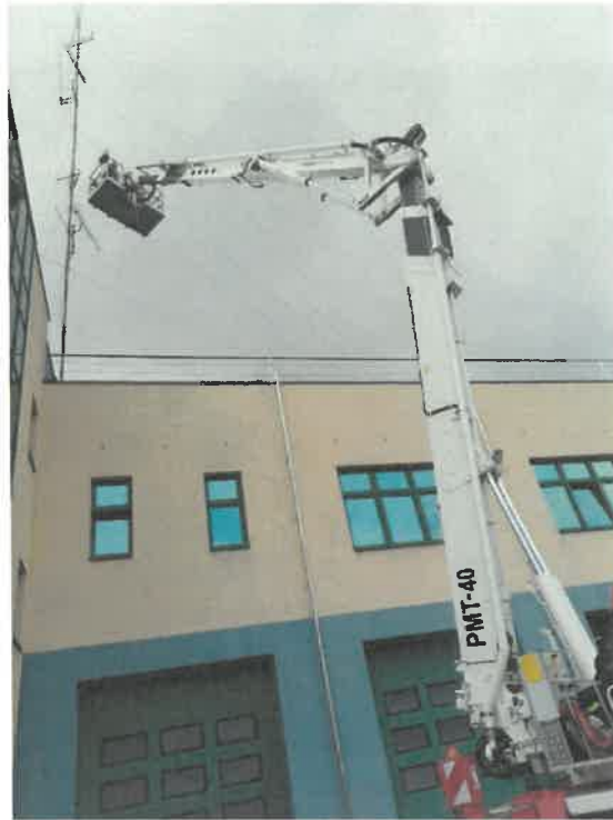
Naprawa i konserwacja masztu antenowego.
